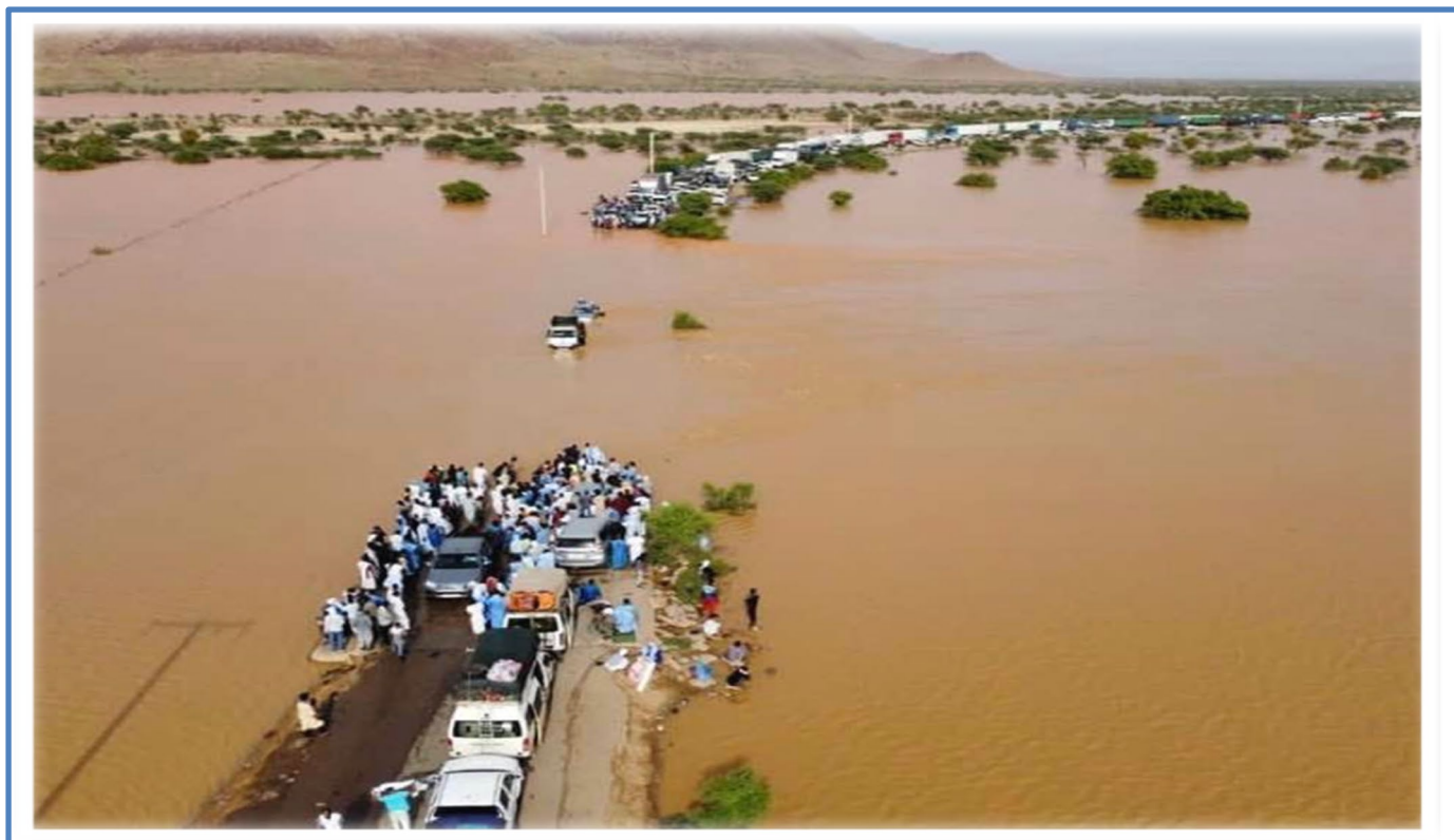
Zone envahie par les eaux dans le Brakna (Assaba)
